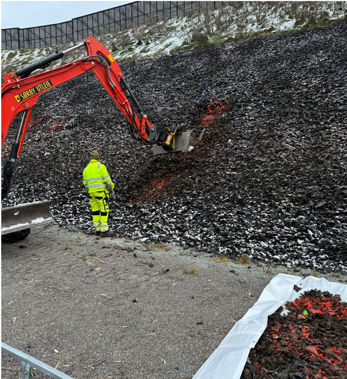
Figur 1 Skaving av lag med dekk-klipp
